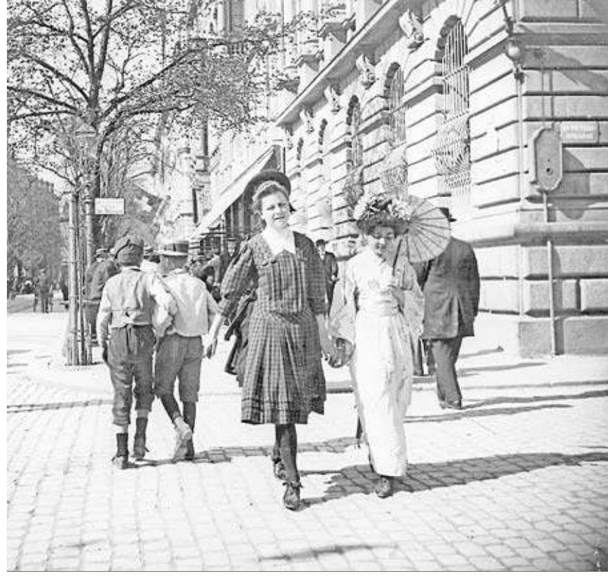
Foto: Baugeschichtliches Archiv der Stadt Zürich/zvg.
