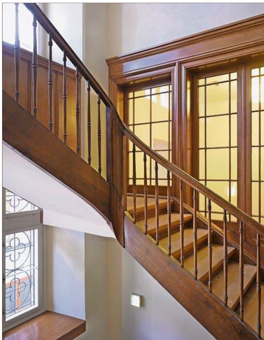
Im Treppenhaus der Helferei wurde sanft renoviert. Foto: Franz Rindlisbacher
